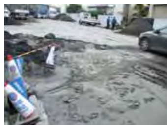
地盤の相対的な動きによる 迫上がり 5 8-36号線(鉄鋼通り)
