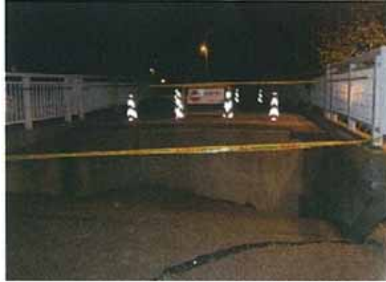
写真 2-1 通行止め状況例（美浜第二歩道橋）
