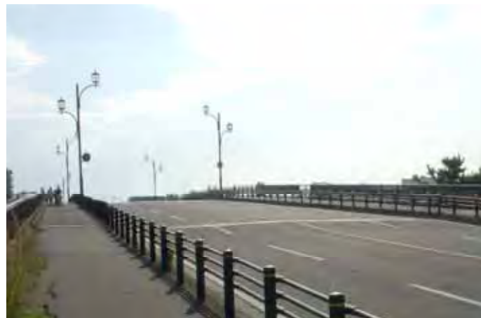
写真 1.2-1 高洲橋の橋台取付部の変状状況
