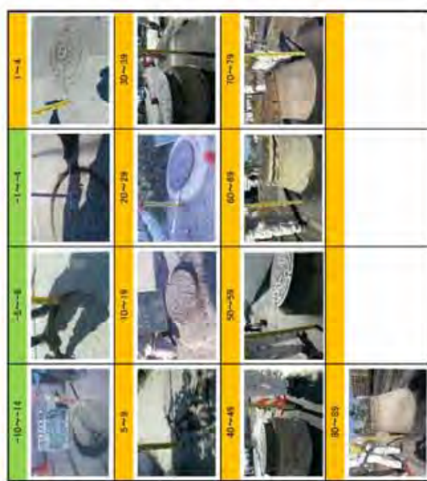
沈下・浮上マンホール写真
