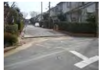
道路被害小（被災程度例）
