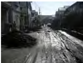
道路被害大（被災程度例）
