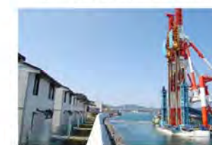
写真-3 民家近接施工状況
