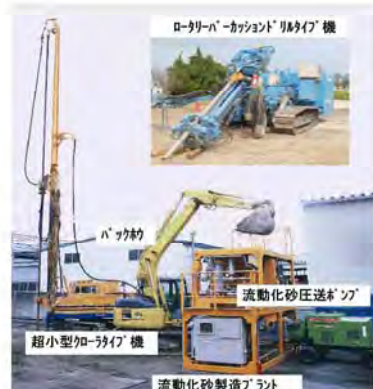
施工システム全景
