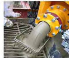
圧送される材料砂の状態
