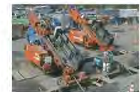
施工状況 (海底トンネル直下)
