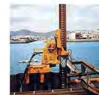
ハイドレールパイル (HDP) の施工状況
