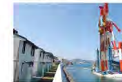
写真-3 民家近接施工状況
