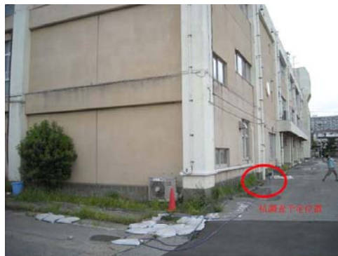
入船南小学校 (PHC、地盤改良有り)
