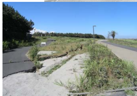
日の出護岸(写真上)と その内陸側の緑地(写真下)
