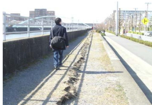
河川護岸(境川)
