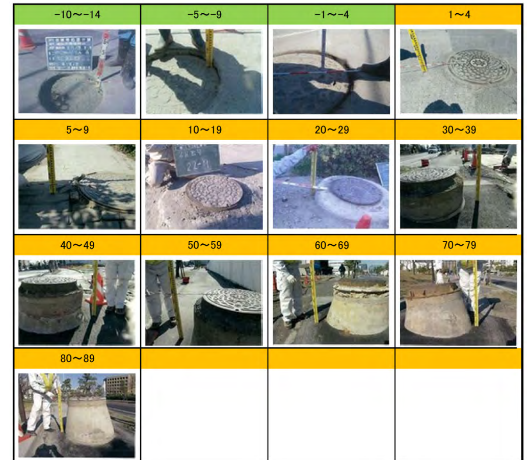
沈下・浮上マンホール写真
