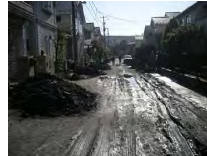
道路被害大（被災程度例）
