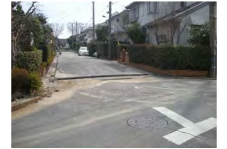
道路被害小（被災程度例）
