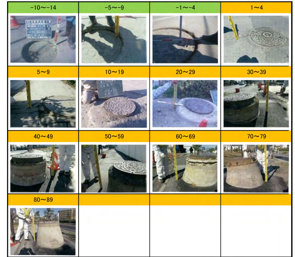
沈下・浮上マンホール写真
