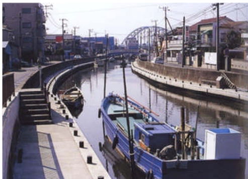
△眺望点としての橋梁から見た川筋の景観
