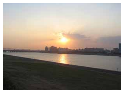
▲舞浜付近の緩傾斜護岸
