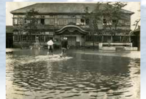
キティ台風で被害を受けた浦安小学校 濁流が田畑を押しつぶし、家財を上げる暇もないほどの速さで家々を襲いました。
