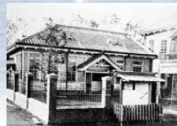
浦安町役場 和洋折衷造りの当時としては極めてモダンな建物で、県下にその偉容を誇ったと言われています。
