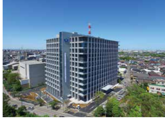
新庁舎竣工 市民利用窓口の集約、バリアフリー化、災害時の拠点となる設備を兼ね備えた100年耐用施設として竣工しました。
