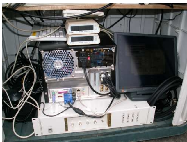
写真4-2-4 自動測定状況
