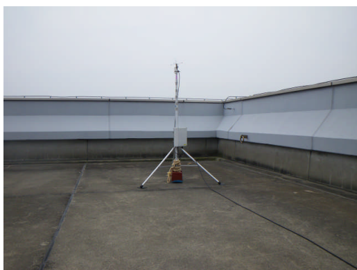
千鳥 航空機識別センサー設置状況
