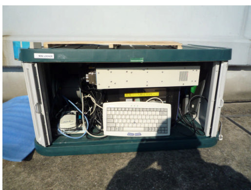
千鳥 音響ベクトル測定器本体設置状況
