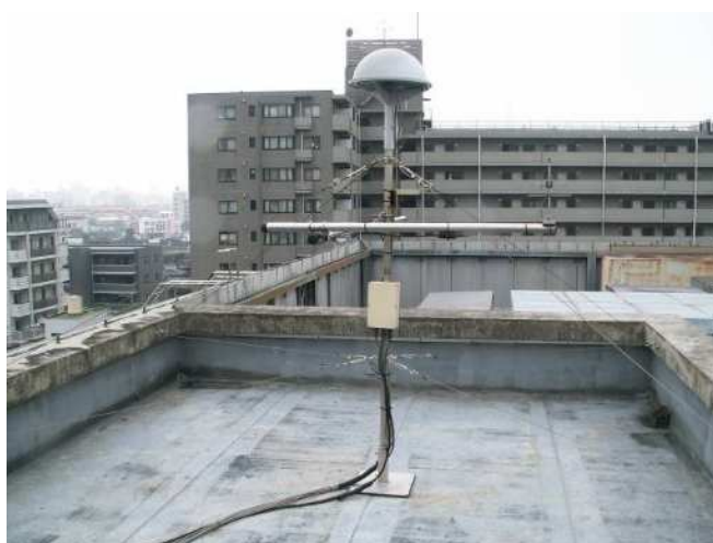
右：航空機接近検知識別センサー 左：航空機最接近検知識別センサー
