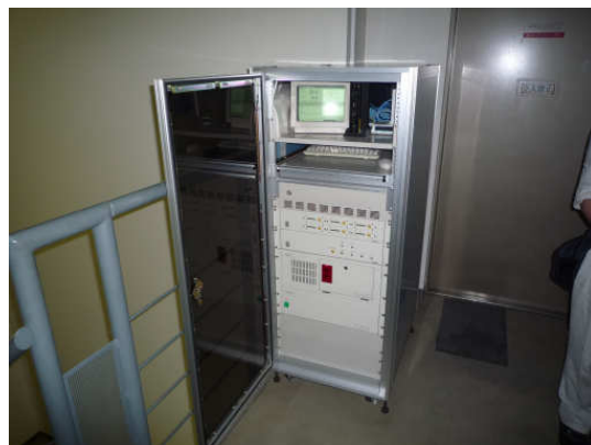
当代島 騒音測定器本体設置状況
