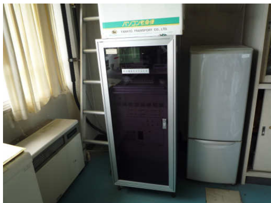
高洲 騒音測定器本体設置状況
