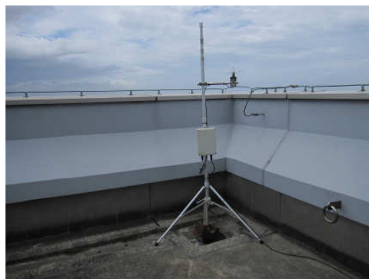
千鳥 航空機識別センサー設置状況
