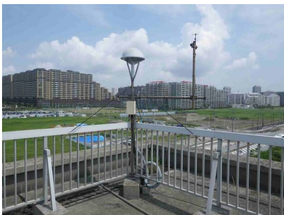
高洲 航空機識別センサー設置状況
