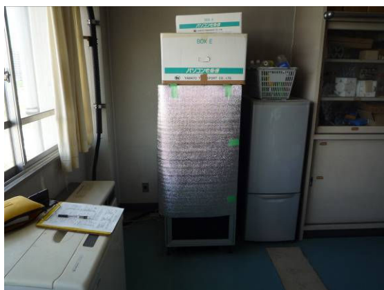
高洲 騒音測定器本体設置状況
