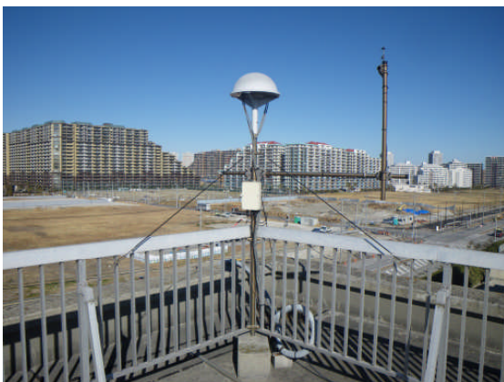
高洲 航空機識別センサー設置状況
