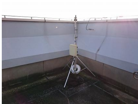
千鳥 航空機識別センサー設置状況
