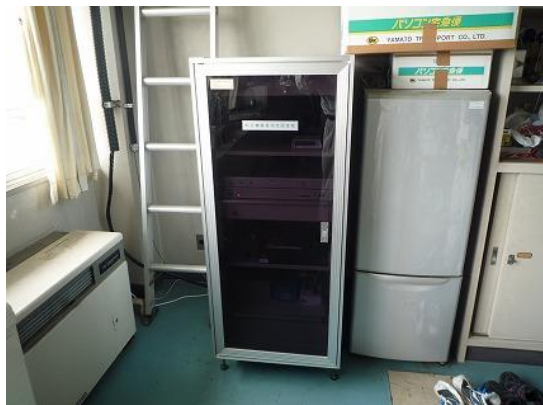
高洲 騒音測定器本体設置状況
