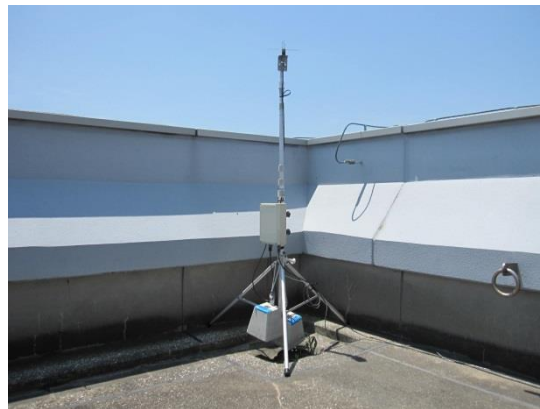
千鳥 航空機識別センサー設置状況
