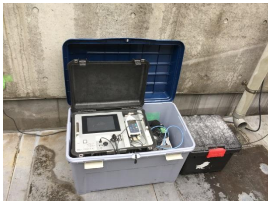
当代島 騒音測定器本体設置状況
