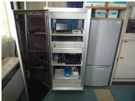
高洲 騒音測定器本体設置状況
