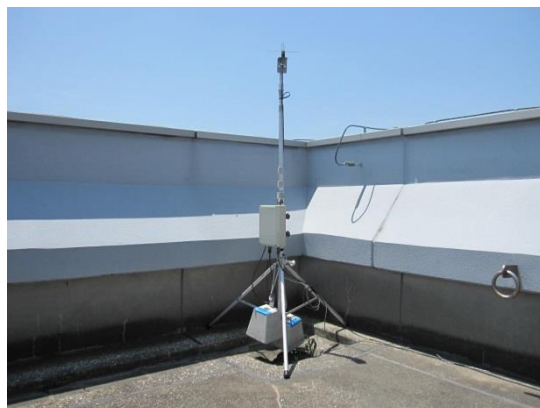
千鳥 航空機識別センサー設置状況
