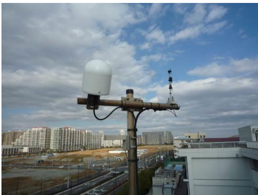
高洲 航空機識別センサー設置状況
