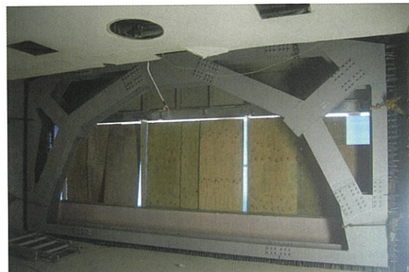
鉄骨ブレースによる壁補強
