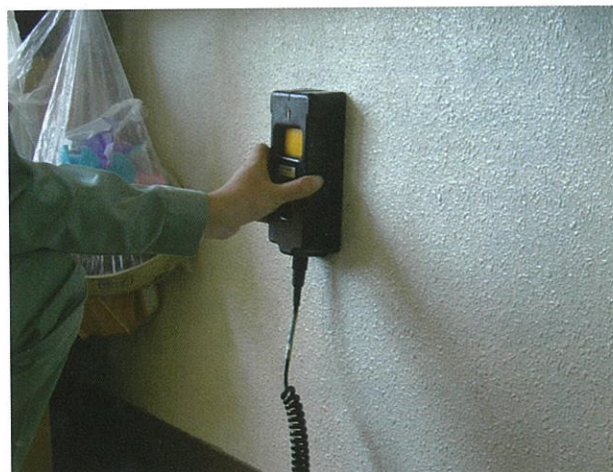
配筋調査(鉄筋探査状況)
