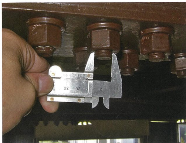
高力ボルト径測定調査
