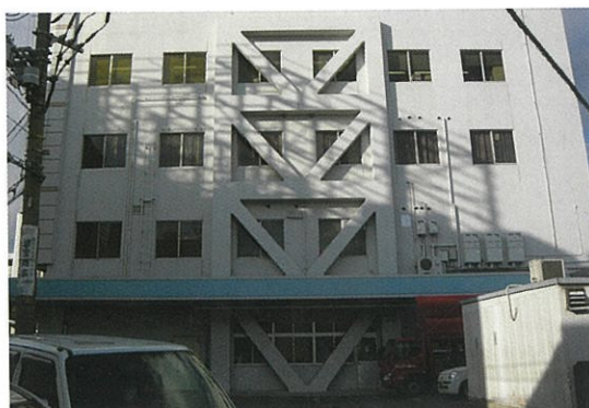
外部鋼管ブレースによる補強
