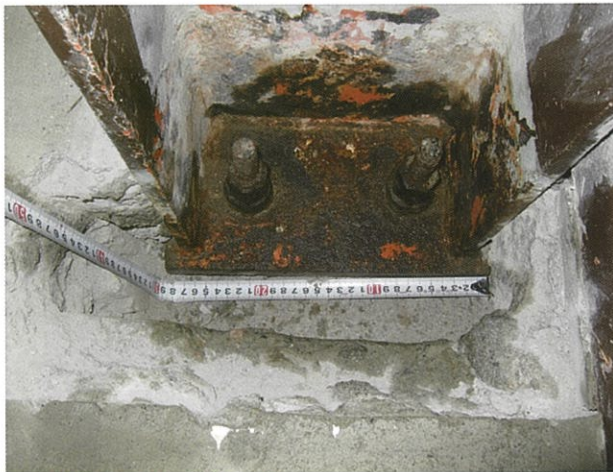
柱脚部調査(接合、発錆状況)
