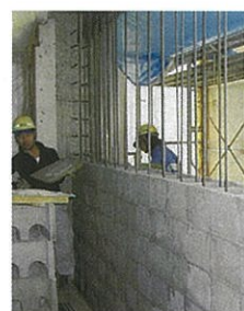
低振動・騒音、省スペース施工が可能な工法による耐震壁
