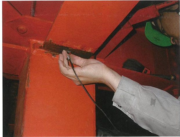
溶接接合部調査(UT試験状況)
