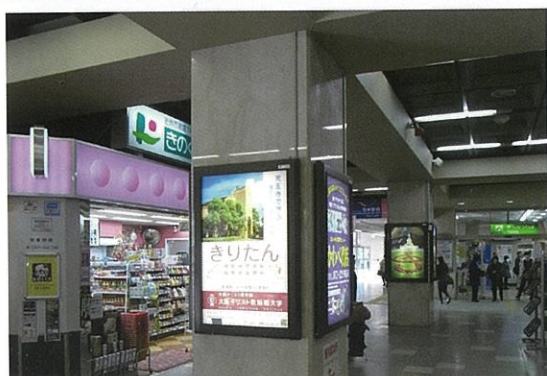
補強した柱を広報スペースに活用
