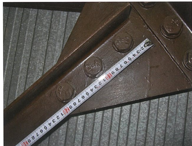
ブレース接合部調査
