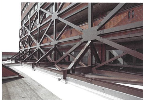
内部補強で狭くなる場所の手前に枠組み鉄骨ブレースを利用した棚を設置
