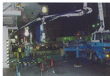
グラウトによる壁新設部(鉄板型枠・鉄筋)
