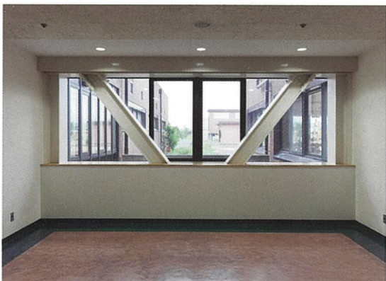
スタッフのスペースは枠組み鉄骨ブレースによる内部補強
