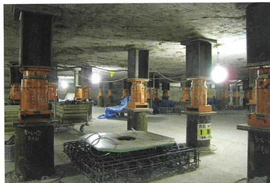
免震耐震改修により百貨店の店舗の大部分を閉鎖することなく営業を行いながら施工
