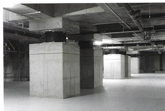
免震耐震改修により百貨店の店舗の大部分を閉鎖することなく営業を行いながら施工
